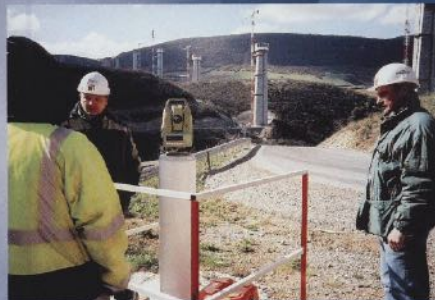
Bau des Viaduc de Millau 2003 mit Lasertheodolit.
