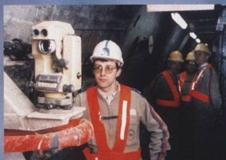
Oben: Richtungskontrolle der Vortriebsmaschine im Eurotunnel 1987 mit Elektroniktheodolit Wild T1600 und Infrarollaser-Distanzmesser Wild DI3 aus Heerbrugg.
